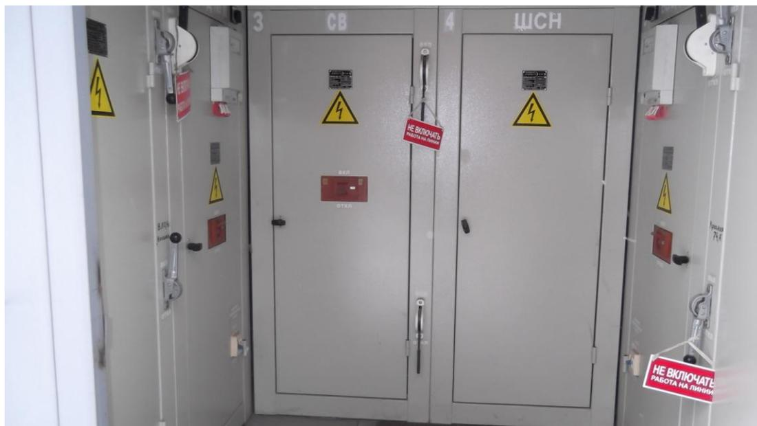
Рисунок 7 – Общий вид РУ-0,4 кВ ТП, КТП.
