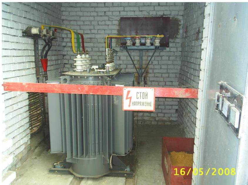
Рисунок 14 – Трансформатор марки ТМГ на ПС ЗАО «ПГЭС».
