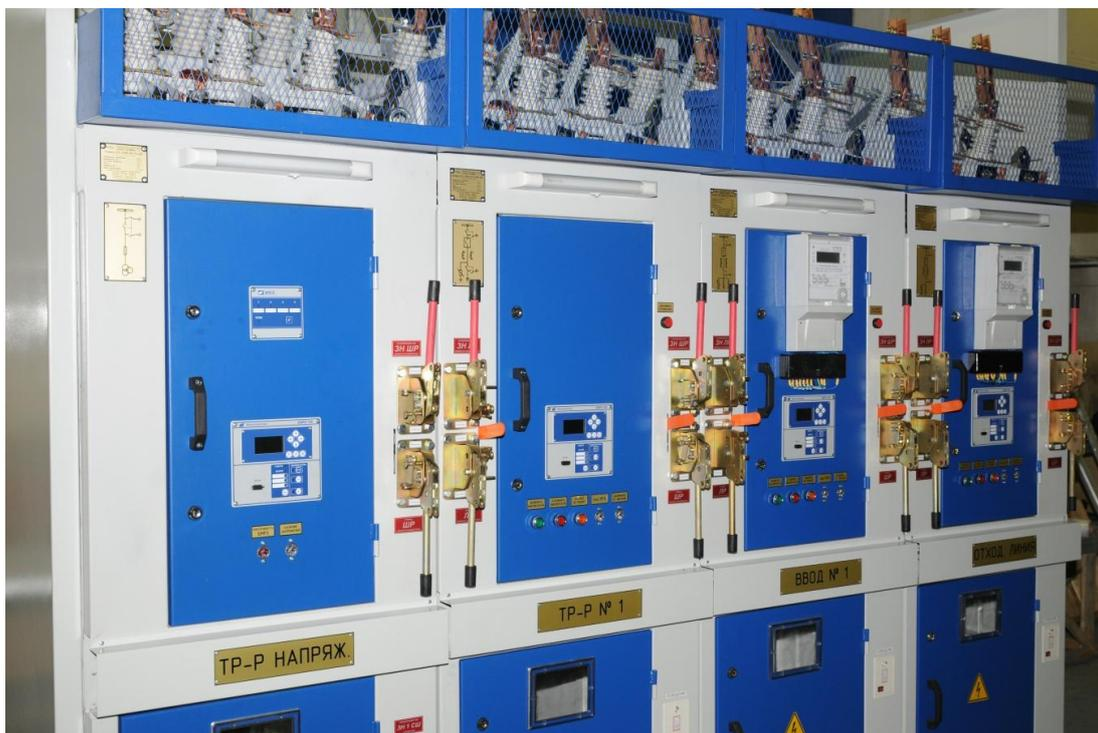
Рисунок 9 – Общий вид РУ-6(10) кВ в РП(РТП).
