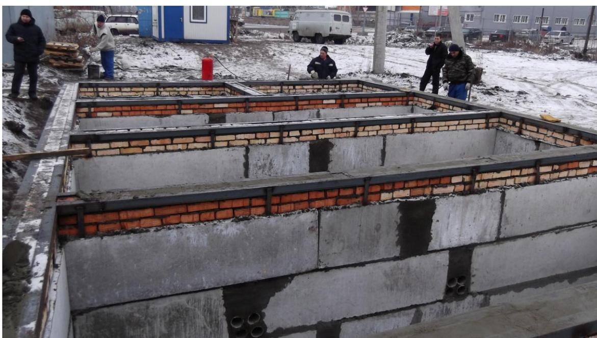
Рисунок 15 – Строительство фундамента под блочный РТП персоналом ЗАО «ПГЭС».
